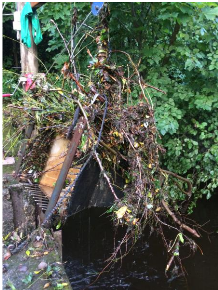
Figur 8. Kvist og driv samler seg raskt opp på fisketelleren i Sandvikselva når vannføringen stiger raskt. Her ca. en dags «fangst» (Foto: M. Merkesdal).
