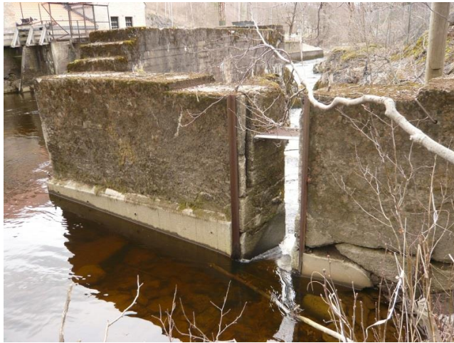
Figur 7. Åpningen i dam-muren ved den gamle kalkmølla (Foto: M. Merkesdal).
