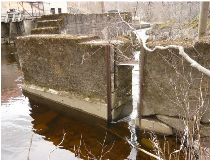
Figur 4. Åpningen i dam-muren ved den gamle kalkmølla (Foto: M. Merkesdal).
