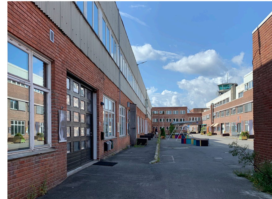
Fig 57: Fasadene i verkstedsgata / kulturgata sett mot Flytårnet ( Foto: Bærum Kommune)
