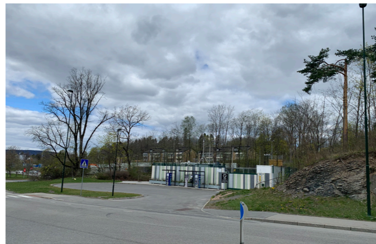
Uheldig plassering av stasjon.
