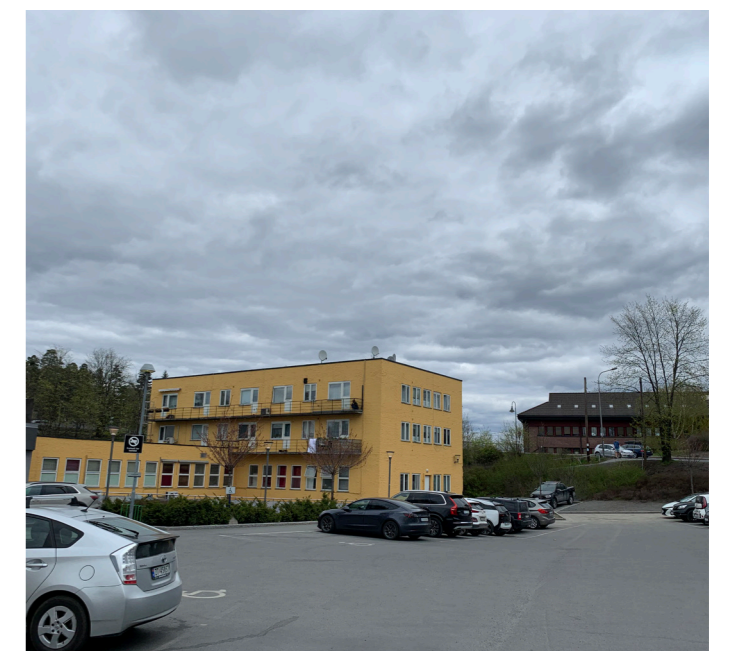
Mange asfalterte parkeringsarealer og utflyttende byrom.
