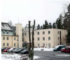
Tilbygg til Godthaab fra 2005: 4 etasjers inngangsbygg med f rmarkering 3 etasjers pasientbygg med flatt tak
