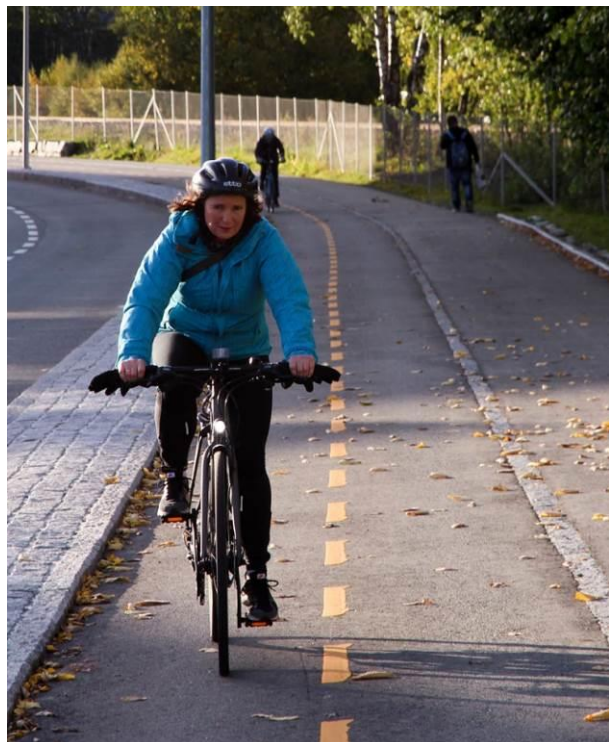
Sykkelvei med fortau, Oslo. Kjøreretning markert i sykkelveien med oppmerking.
