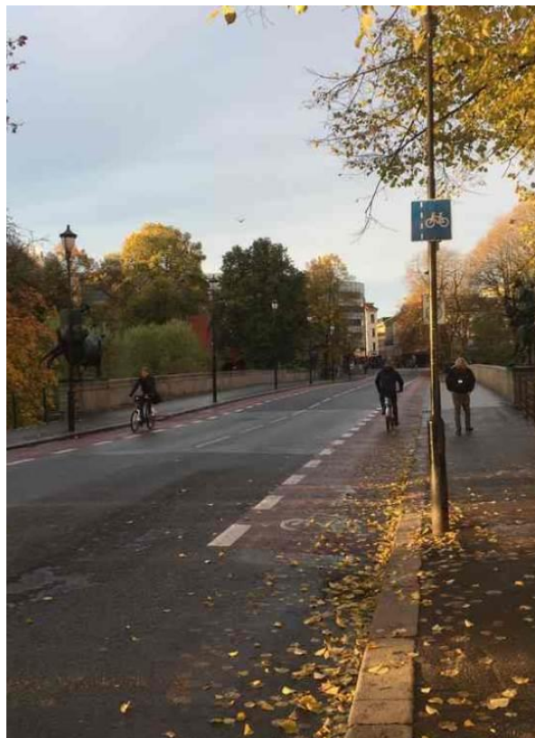
Sykkelfelt Ankerbrua, Oslo
