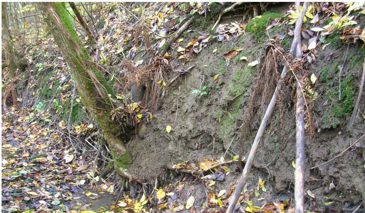
Rasutsatte leirjordkanter ned mot øverlandselva. Elva graver i underkant av jordskråningene ved flom noe som gir gunstige forhold for pionerarter av moser.
