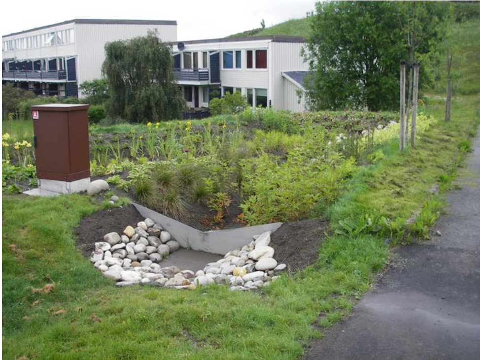
Eksempel på regnbed etablert i borettslag i Trondheim (foto;B.C.Braskerud)
